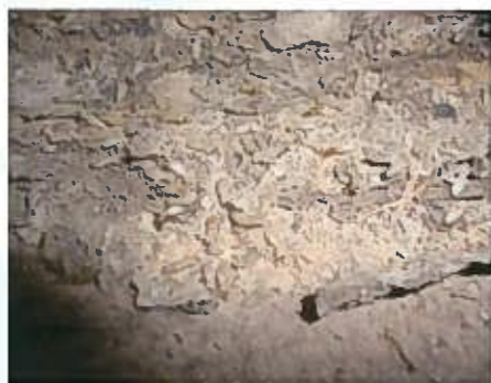
写真1 フローリング下地やベニヤに生息するイエシロアリ
