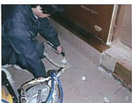
写真8 玄関土間処理
