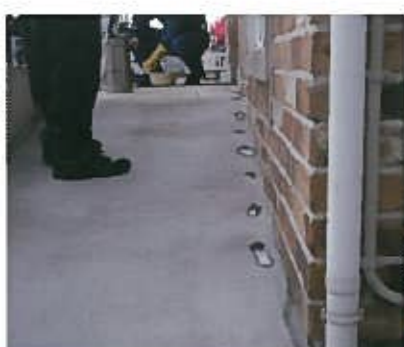
写真9 スロープ処理
