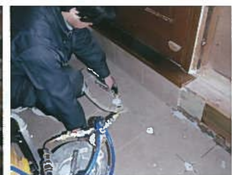
写真8 玄関土間処理
