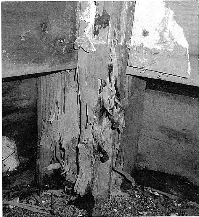
アメリカカンザイシロアリに食われた家の柱。下にある大量の粒がシロアリのフンだ
