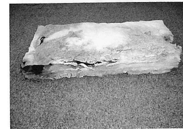
②断熱材の被害
