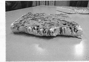
④断熱材の被害
