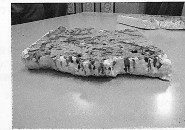
写④ 断熱材の被害
